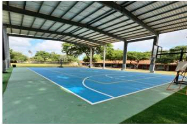
Intervención de cubierta y cambio de piso del gym de Elemental
